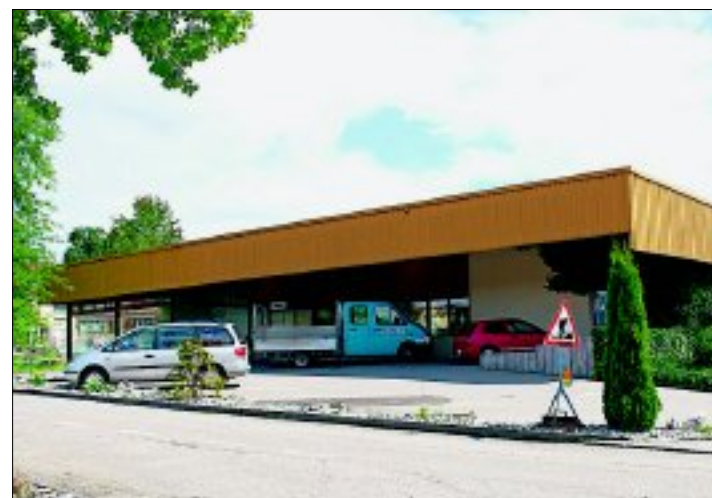
Auf dem Gelände des ehemaligen Gartencenters Wyss wird als Erstes eine Tankstelle mit Shop gebaut. (Bild Josef Kottmann)
